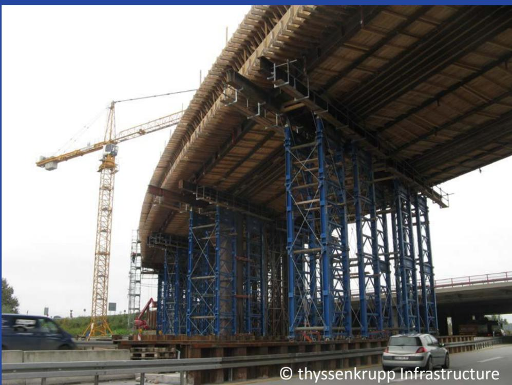
Die Herstellung von langen Talbrücken in tief eingeschnittenen Tälern wird mit einem verschiebbaren Lehrgerüst ohne Zwischenunterstützungen ermöglicht. Ein Vorschubgerüst transportiert dabei die gesamte Schalungskonstruktion und die Spannglieder in das jeweils nächste zu betonierende Brückenfeld. Auf diese Weise können Montageaufwand und Taktzeiten minimiert werden. Bodenunabhängig können so auch Flüsse und Verkehrswege stützenfrei gekreuzt werden.
