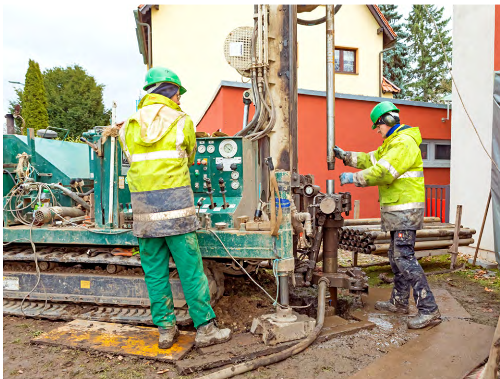
Wer in die Tiefe will, braucht schweres Gerät: Spezialtiefbauer der Firma SBS bohren auf dem Grundstück eines Architekturbüros in Markkleeberg, um eine Erdwärmesonde zu legen
