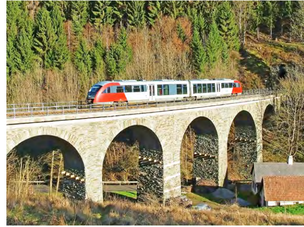
Das 1908 fertiggestellte Ungerbach-II-Viadukt
